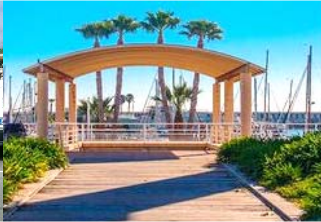
Vista de la coberta de policarbonat de les escales
