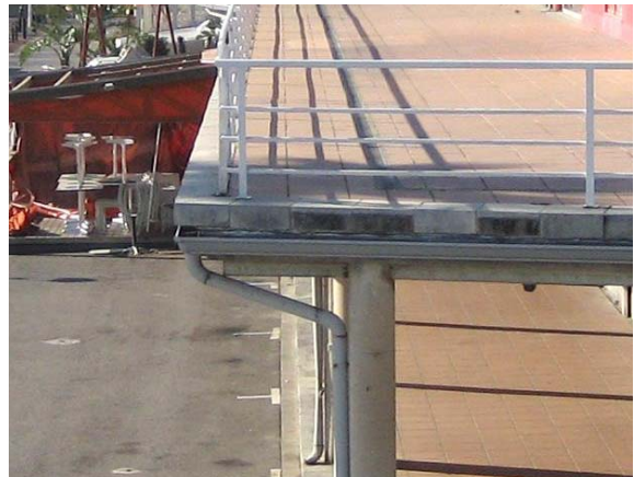
Detall de la imposta, del canaló afegit i del baixant
