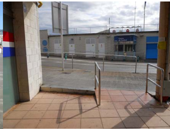
Encontre rampa amb línia de porxada
