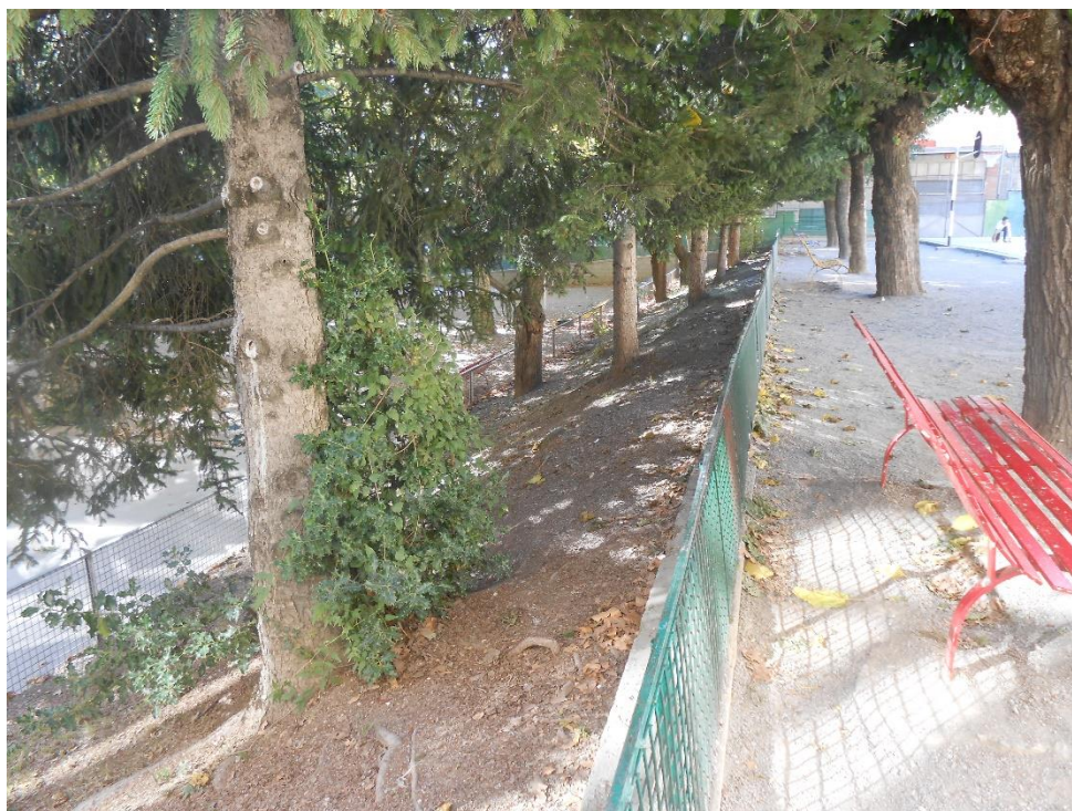
Desnivell entre els dos patis
