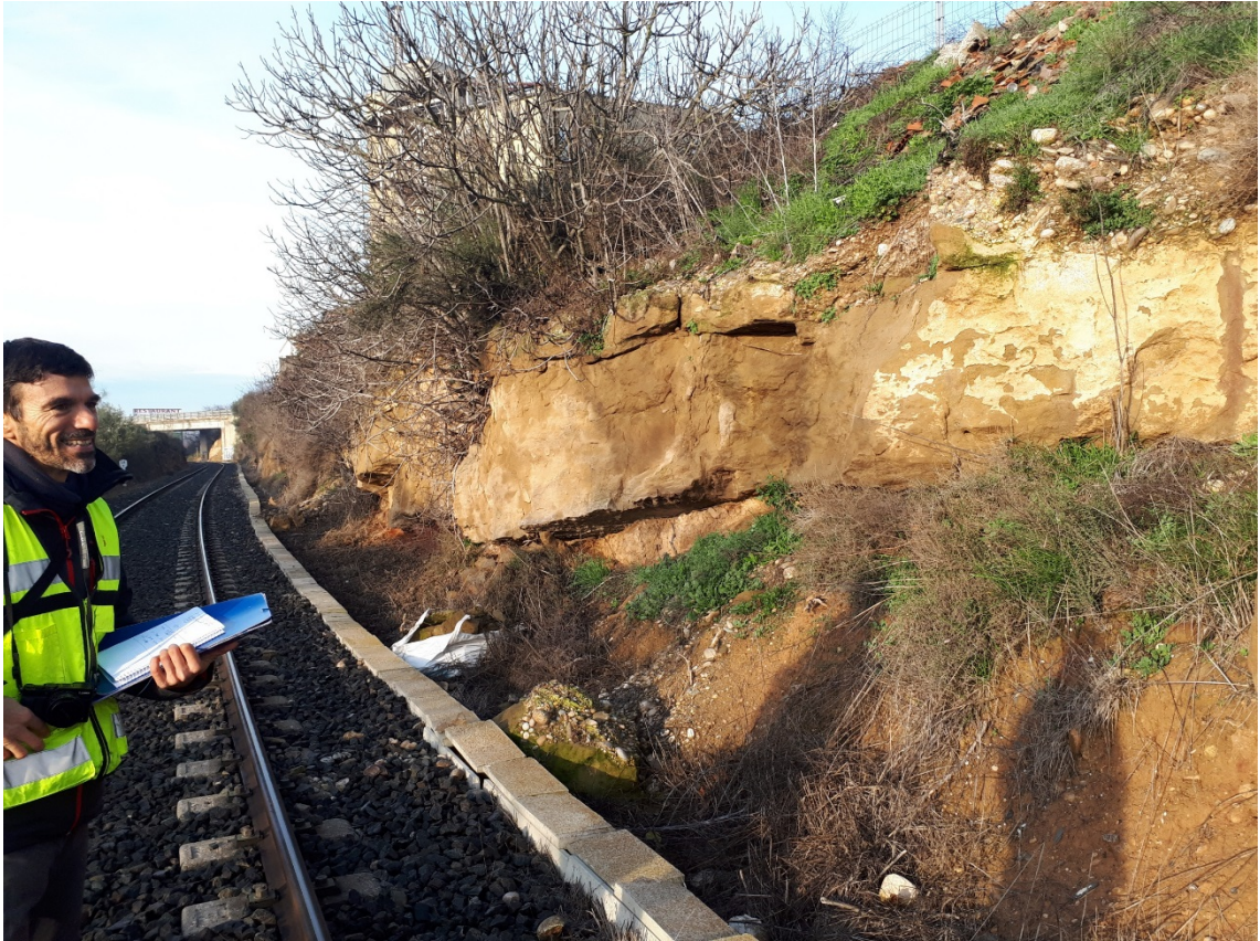
Talús LM 1 LPS
