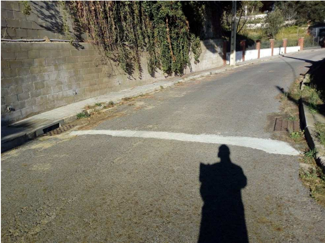
Creuament de carrer amb formigó al carrer Roure que també procedirem a deixar asfaltat
