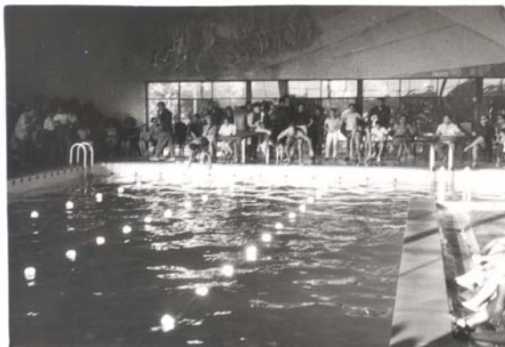
Interior Edifici Tabaris .
