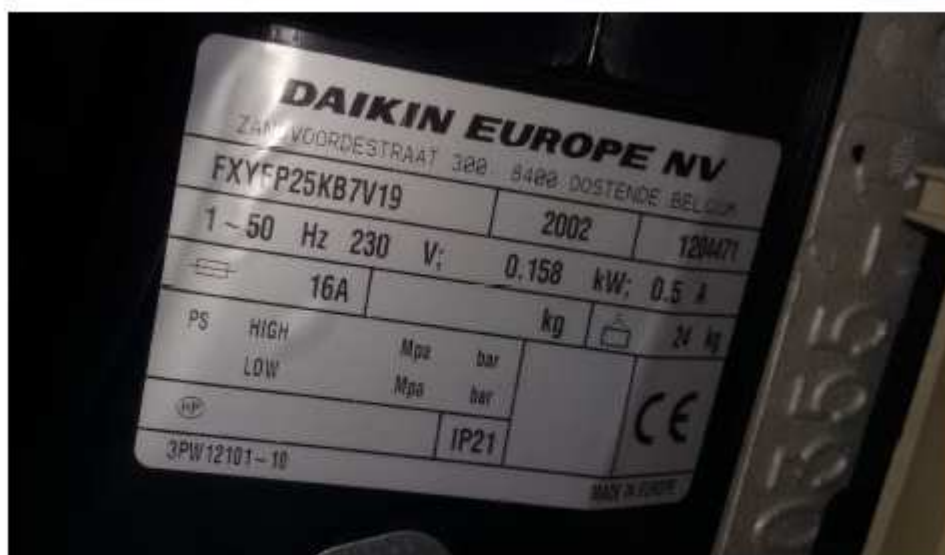
Equip de climatització tipus cassette de sostre i placa de característiques de la unitat interior, de la casa Daikin
