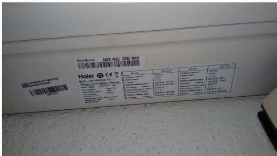
Equip de climatització tipus split i placa de característiques de la unitat interior, de la casa Haier
