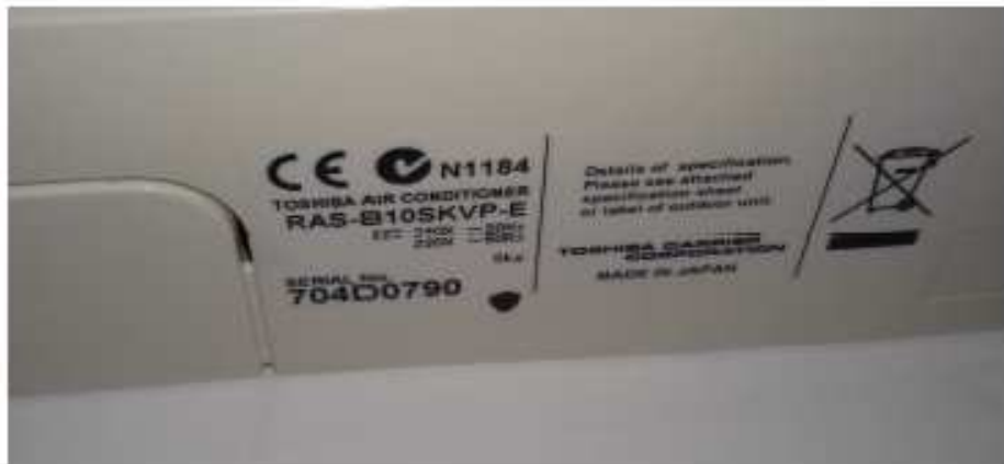
Placa de característiques de la unitat d'interior tipus split, model RAS-B10SKVP-E, de la casa Toshiba
