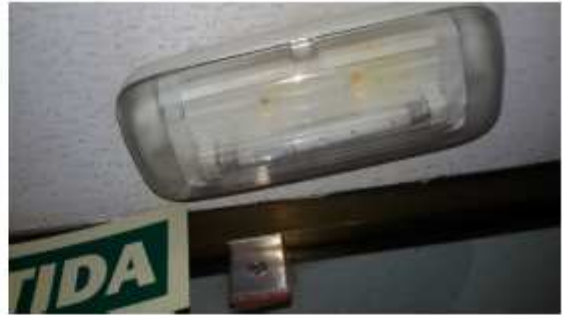
Pantalles de fluorescents i llum d'emergència
