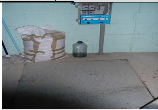
Accés Fossa Sèptica
