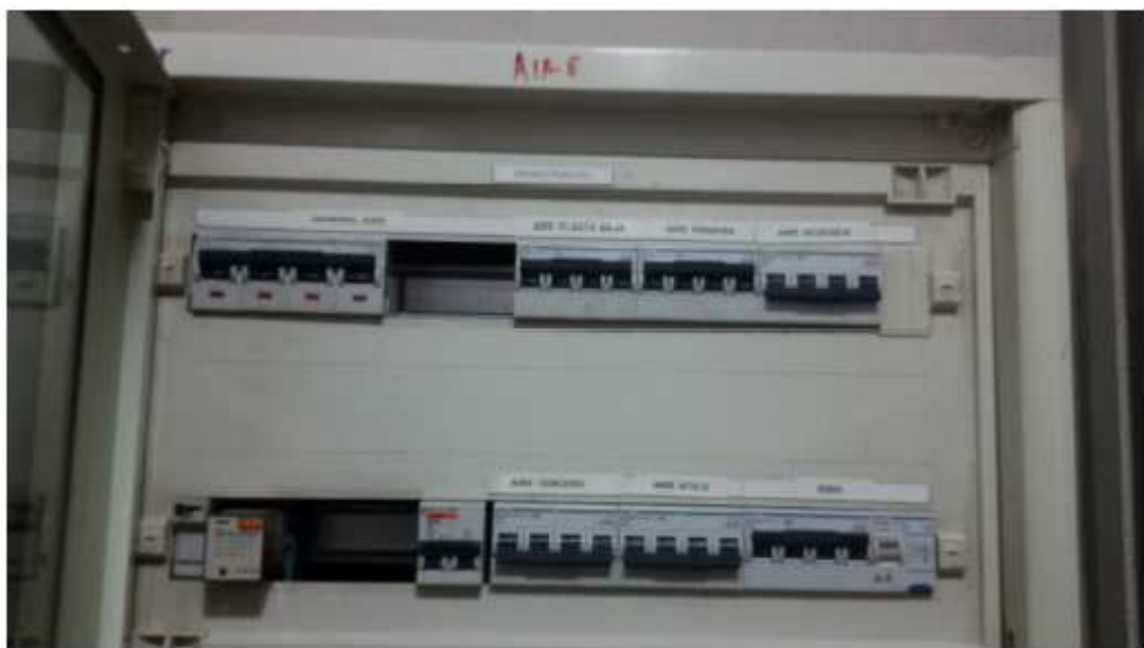
Subquadre aire condicionat planta 1ª
