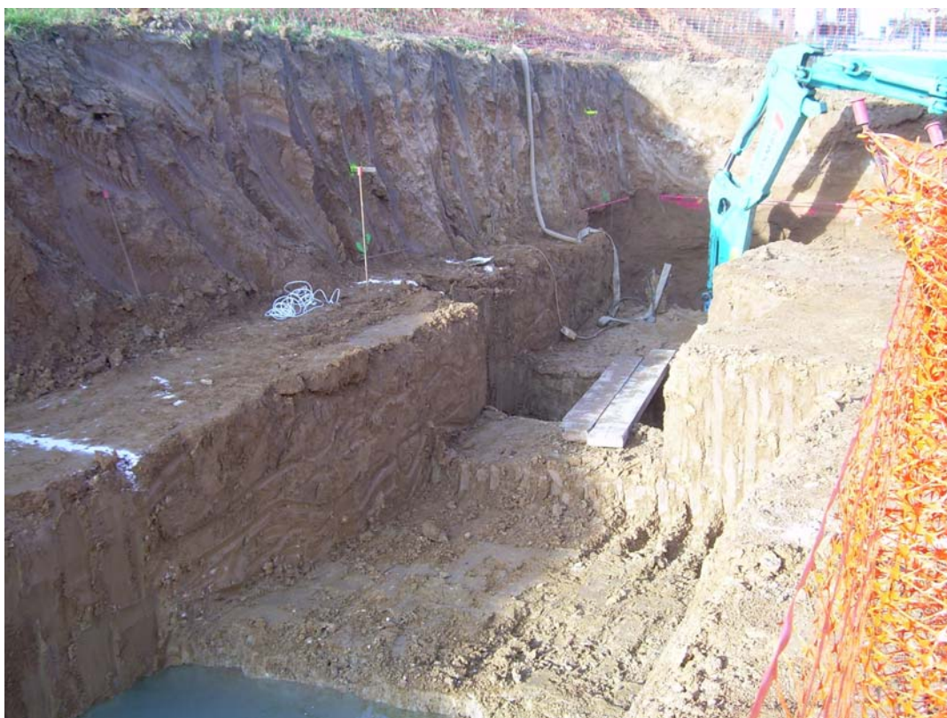
Fotografia 4. Vista general de la rasa de fonamentació NO-SE. Excavació del pou de cimentació del sector més desfavorable (sector NO).
