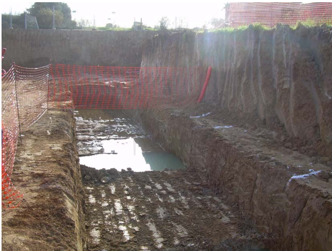
Fotografia 3. Vista general de la rasa de fonamentació NO-SE.
