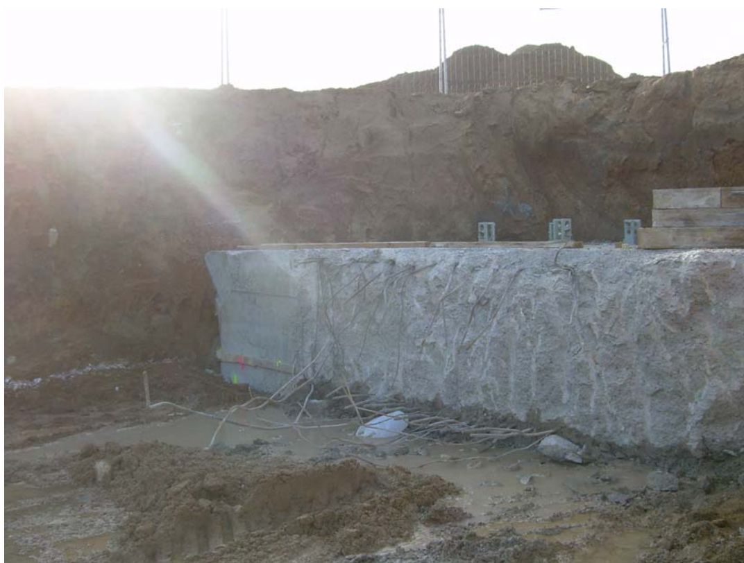
Fotografia 2. Vista de la plataforma que acollirà la grua.
