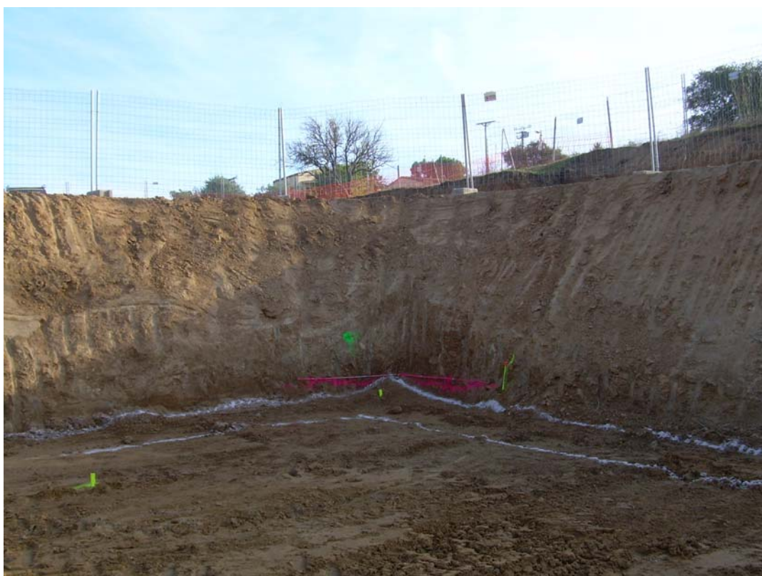
Fotografia 1. Vista extrem SE de l'excavació del vas de la piscina.
