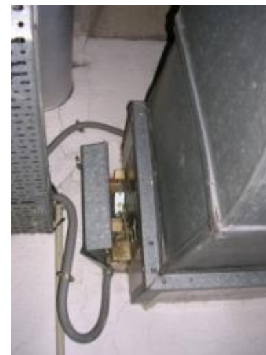
042 Comportes tallafocs conductes
