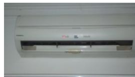
V018 P2 Sala Gran Restauració
