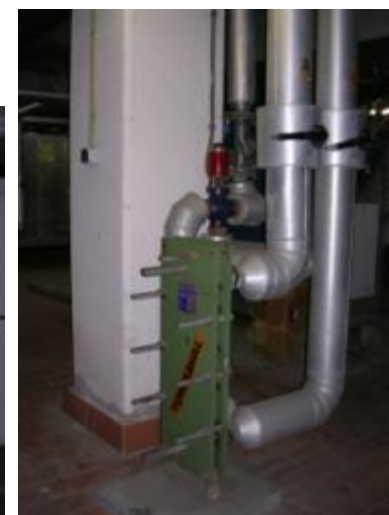
039 Bescanviador plaques Bombes Calor
