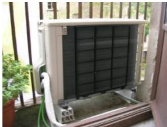
124 Condensadora corresponent amb foto 123
