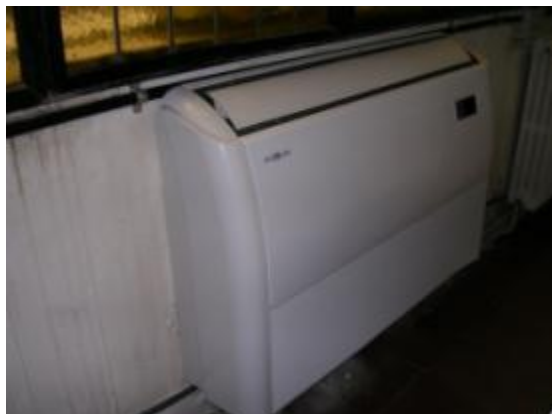
072 Magatzem gravats dreta
