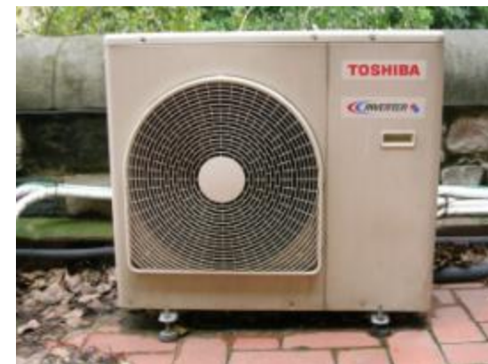
128 Condensadora corresponent amb fotos 125 i 126
