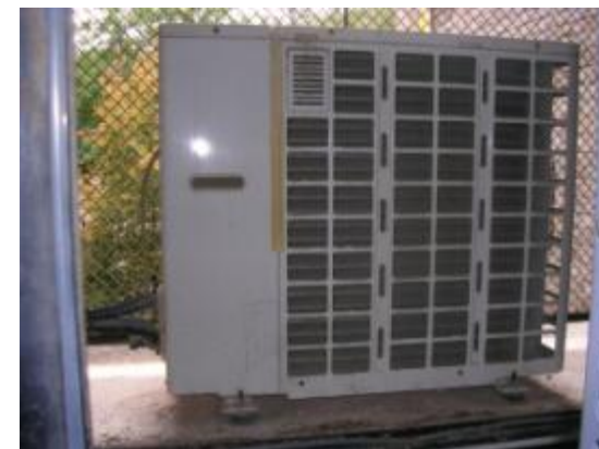
071 Condensadora corresponent amb foto 070
