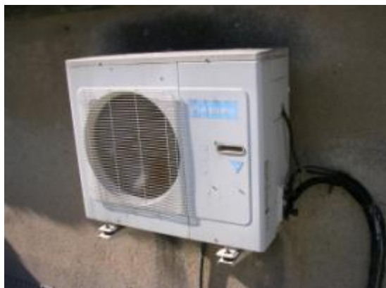
010 Condensadora corresponent amb foto 008
