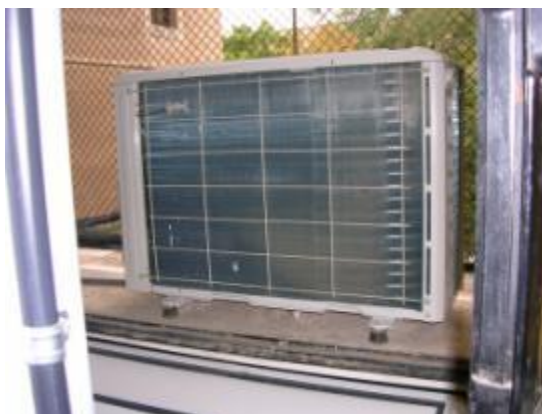
073 Condensadora corresponent amb foto 072
