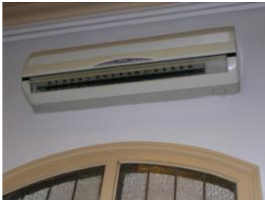
008 Música costat entrada p3 Gardunya
