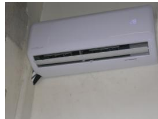
074 Despatx magatzem gravats
