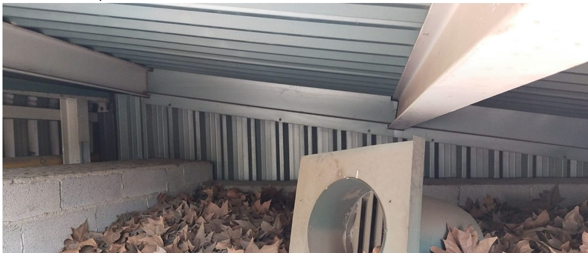
Il·lustració 10 Estat actual de coberta
