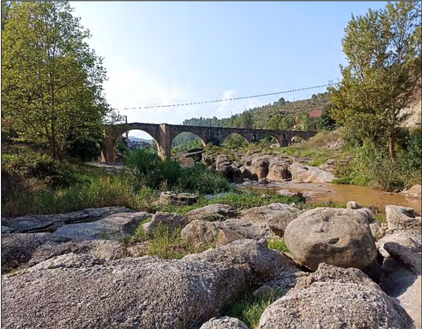
Imatge 9. Zona del Pont de Vilomara que amb els treballs de manteniment de la llera serà una zona més accessible i visible per als habitants del Pont de Vilomara, tot millorant així, la qualitat paisatgística de l'entorn natural del Riu Llobregat.
