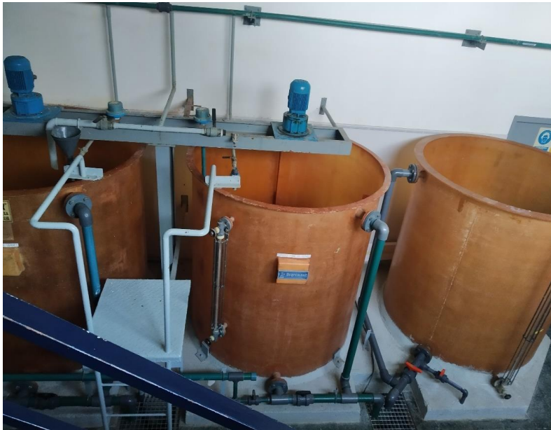
Instal·lacions i equips de la sala de reactius fora de servei a enretirar. Paviment de formigó a tallar i reduir de dimensions
