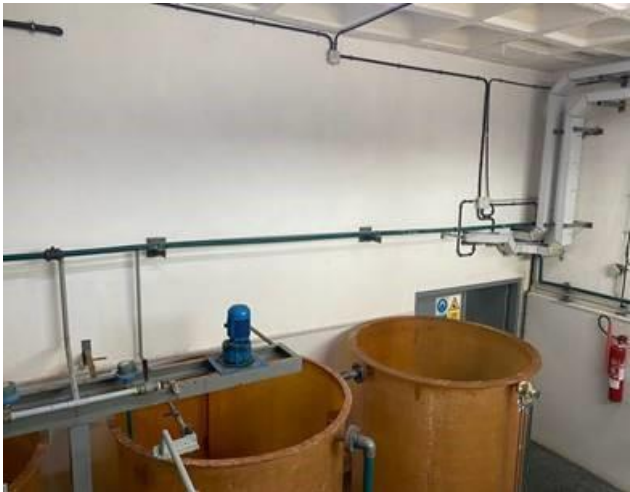
Línies d'aigua i PAX que passen sobre els dipòsits fixades a la paret. Es desmuntaran i es instal·laran per l'altra banda de la paret, per la sala de màquines.
