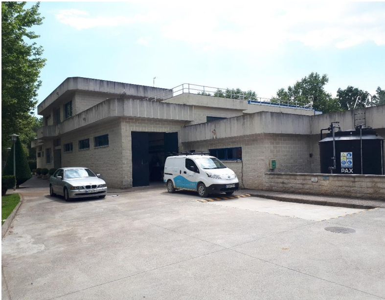
Exterior de la sala de reactius, darrere la furgoneta, amb la finestra on s'obrirà el nou accés
