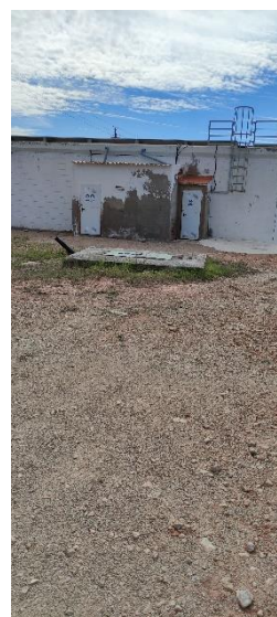
Imatge 2. Vista general de la parcel·la
