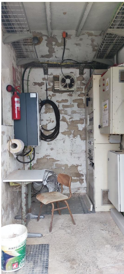
Imatge 3: Caseta de Control. Exterior e interior
