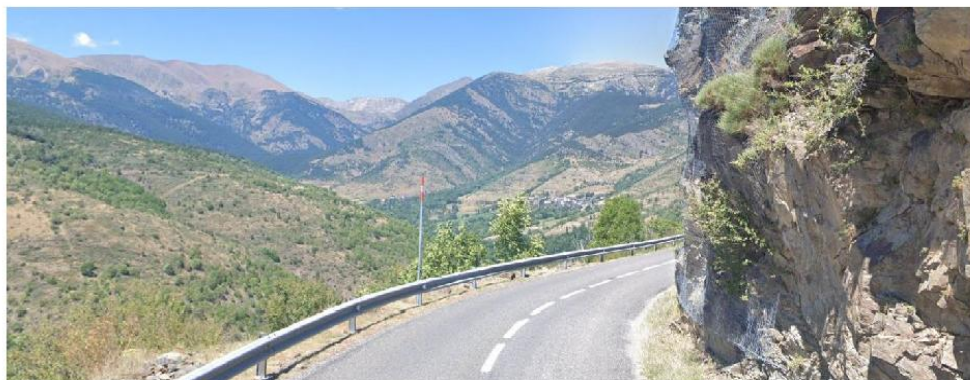
Imatge de la corba al PK 7+460 (marge dret) a la carretera GIV 4031 a Meranges.
