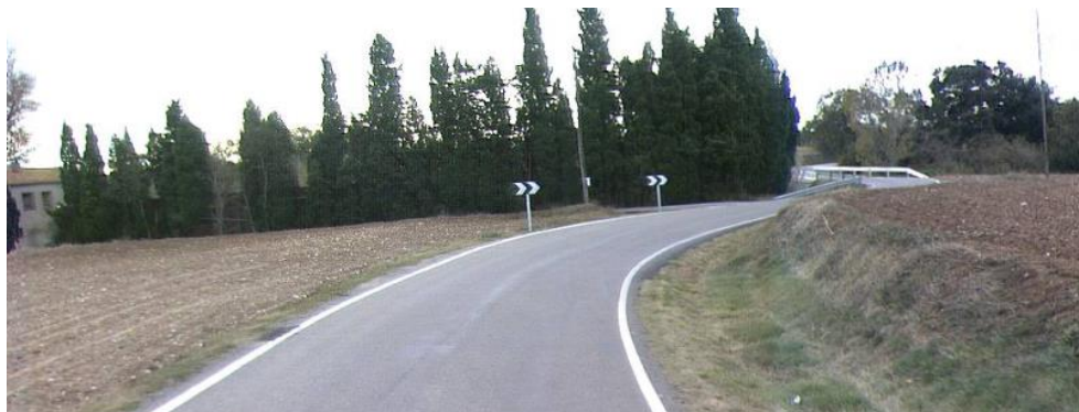
Imatge de la cuneta de terres al PK 1+070 (marge dret) a la carretera GIV-6227, des de Vilamallà en direcció a Garrigàs.
