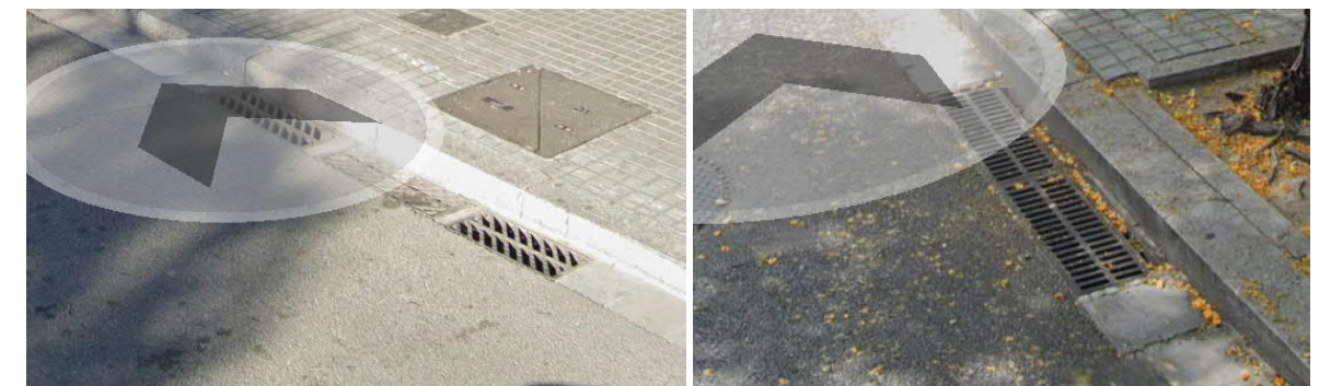
Jocs d'embornals situats a l'inici del carrer Tarragona a ambdós costats de les calçades.
