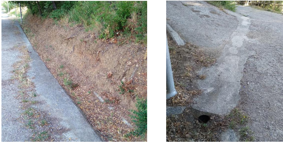
Figures 5.1 i 5.2: Exemples de cunetes i passos salvacunetes existents.
