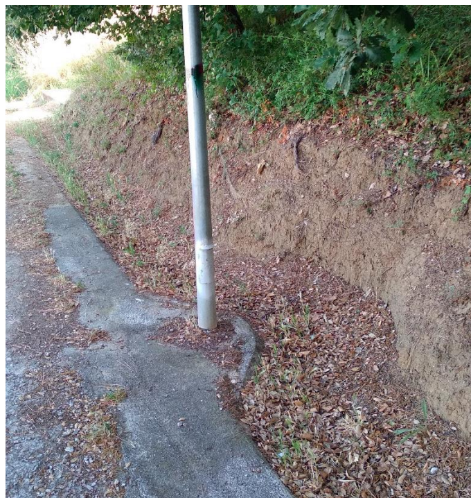
Figura 5.4: Exemple desviament de cuneta.
