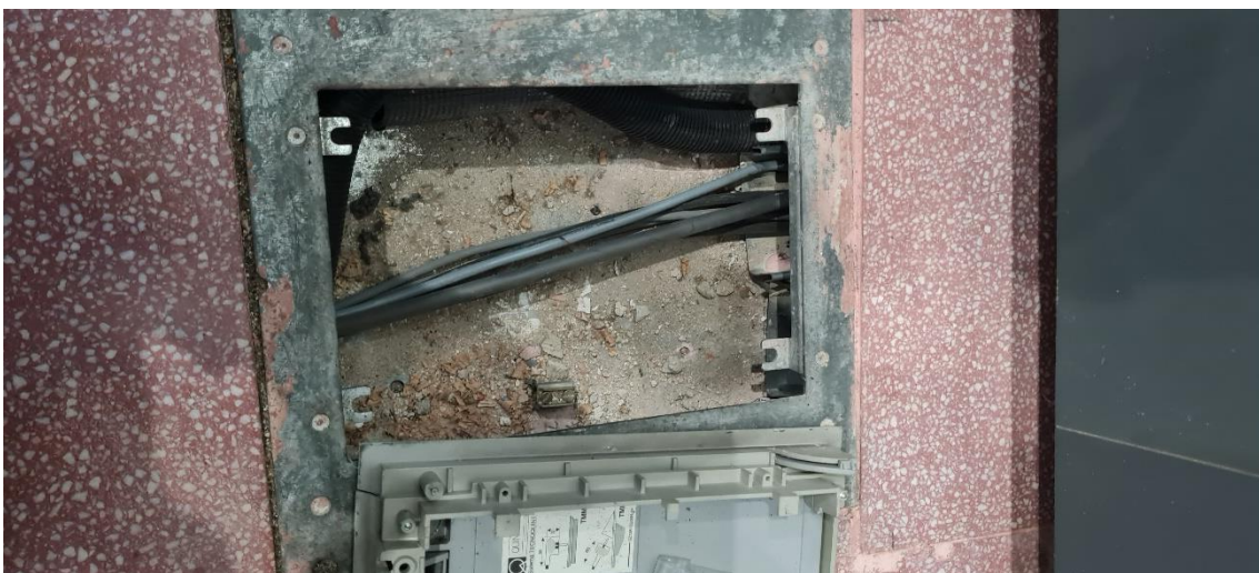
Imatge 11: Canal a terra que va des de la taula del docent fins a les cabines d'interpretació.
