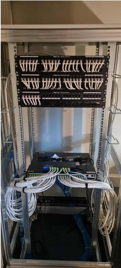
Imatge 6. Armari de comunicacions exclusiu cabines. Els punt de xarxa Ethernet de l'ordinador del docent és a un altre armari de comunicacions, general UAB.
