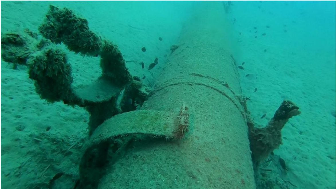
PILOT TRENCAT – CANONADA RECOLZADA EN SORRA
