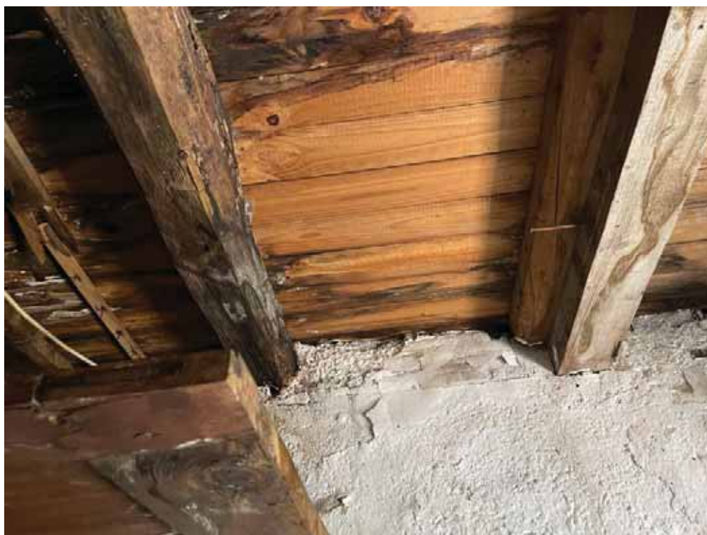
Estructura forjats de fusta.
