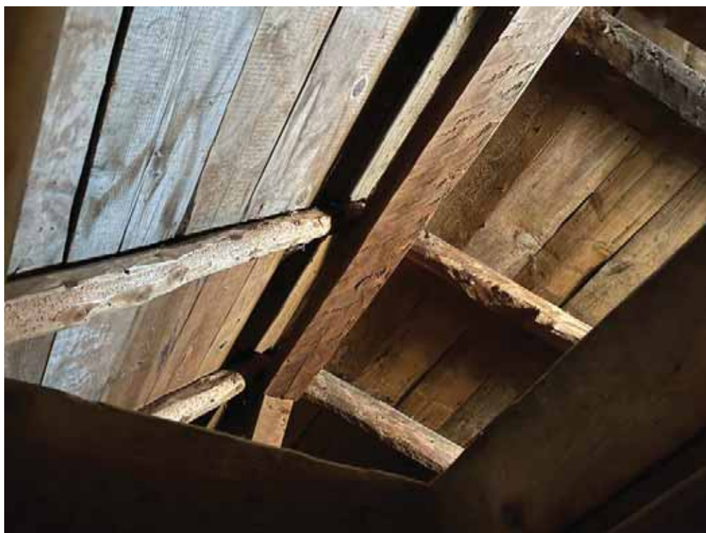
Estructura coberta de bigues de fusta.
