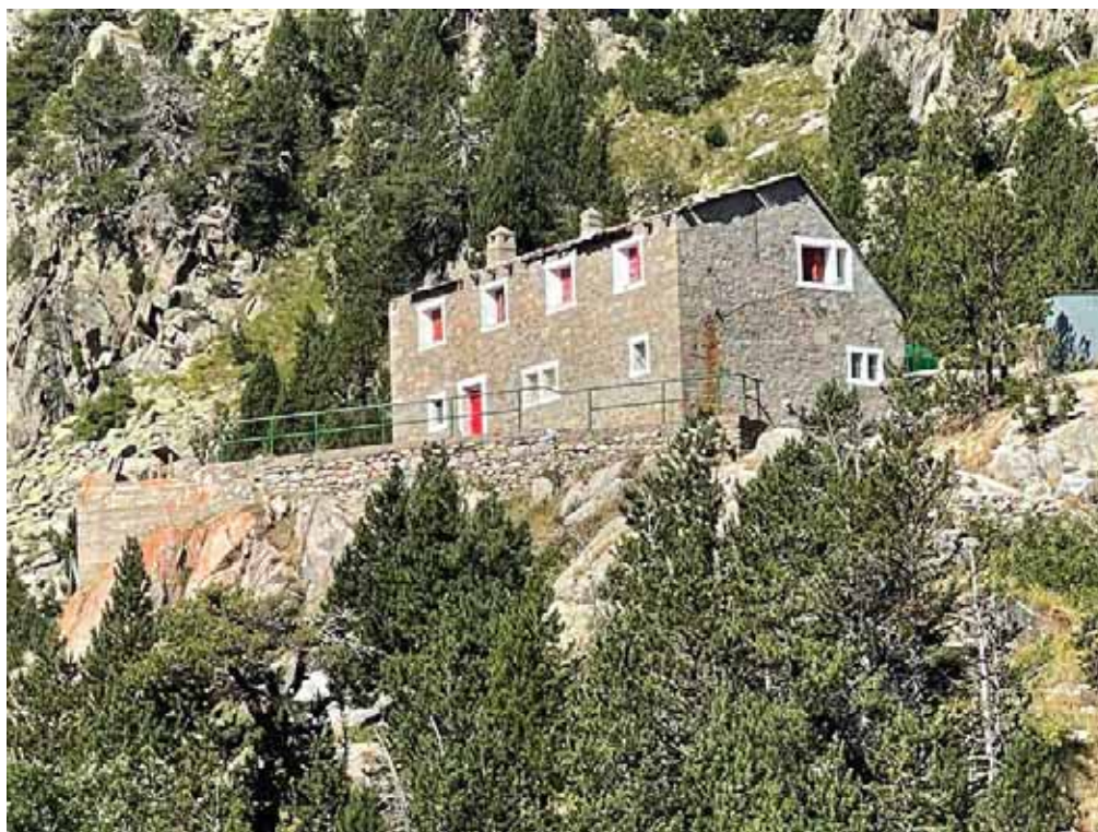
Imatge general de l'edificació, façana principal orientació sud-est
