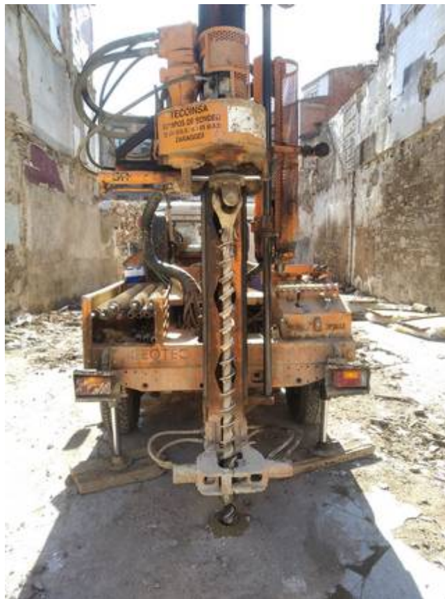
Vistes dels quatre sondeigs realitzats a la zona objecte d'estudi, S-1, S-2, S-3 i S-4 del tipus Rotació helicoidal.
