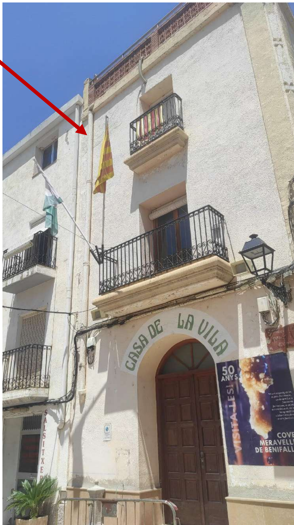
Baixant de fibrociment a la façana de l'ajuntament
