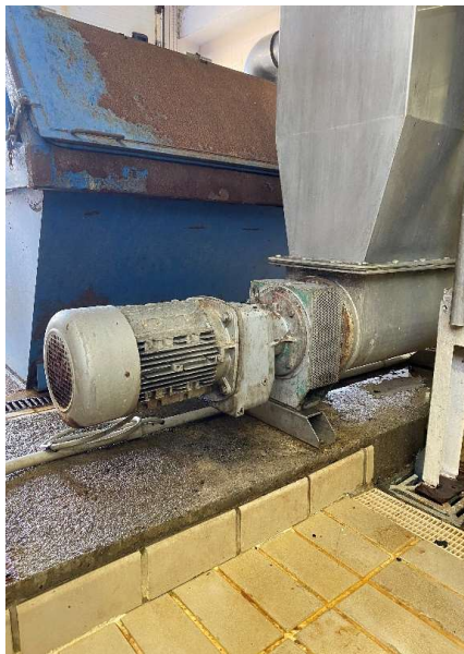
Figura 2.2. Detall de la bomba a substituir
