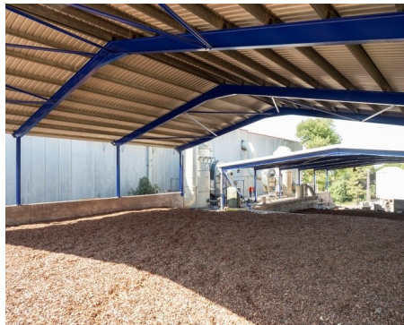
Imatge 2: Biofiltre 2- omplir amb nou reblert
