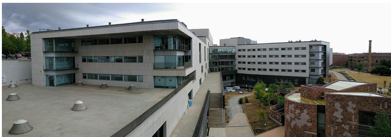
Blocs A i B
